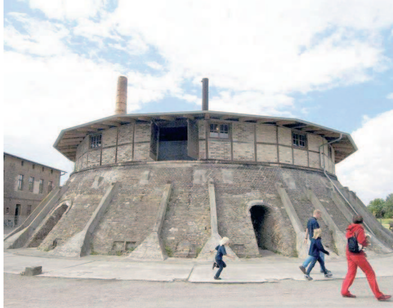
Runde Sache. Der von Friedrich Hofmann erfundene Ringofen auf dem Gelände der Ziegelei. – Foto: dpa
